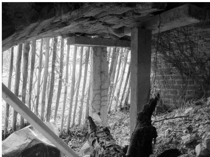
Ingang naar de tuin vanuit de aangetroffen ruimte
