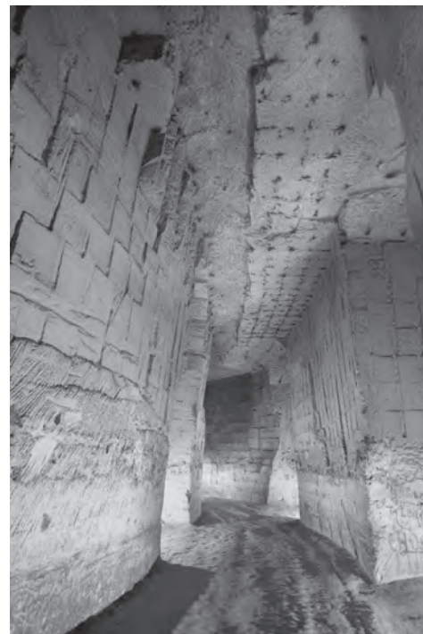
AFBEELDING 6 en 7: De drijfgang tekent zich duidelijk af op het plafond als smalle strook, links op het plafond. Aan het einde de gang ontgonnen met de Kanner blokbreekmethode, waar de doorbraak plaatsvond (foto's Rob Heckers)
