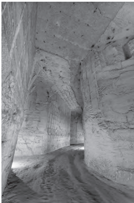
AFBEELDING 6 en 7: De drijfgang tekent zich duidelijk af op het plafond als smalle strook, links op het plafond. Aan het einde de gang ontgonnen met de Kanner blokbreekmethode, waar de doorbraak plaatsvond (foto's Rob Heckers)
