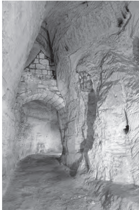
AFBEELDING 14 en 15: Verstevingingen van aangesneden aardpijpen (foto's Rob Heckers)
