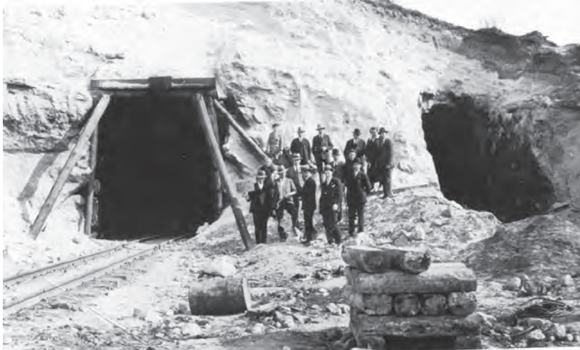
AFBEELDING 14: Twee tunnelingangen, vermoedelijk de oostzijde van de tunnel Lanaye-Emael. Deze waren vrij schuin ten opzichte van de bergwand (Thier de Lanaye) ingeboord. (foto collectie Mathieu Gijbels / Heemkunde Kanne)
