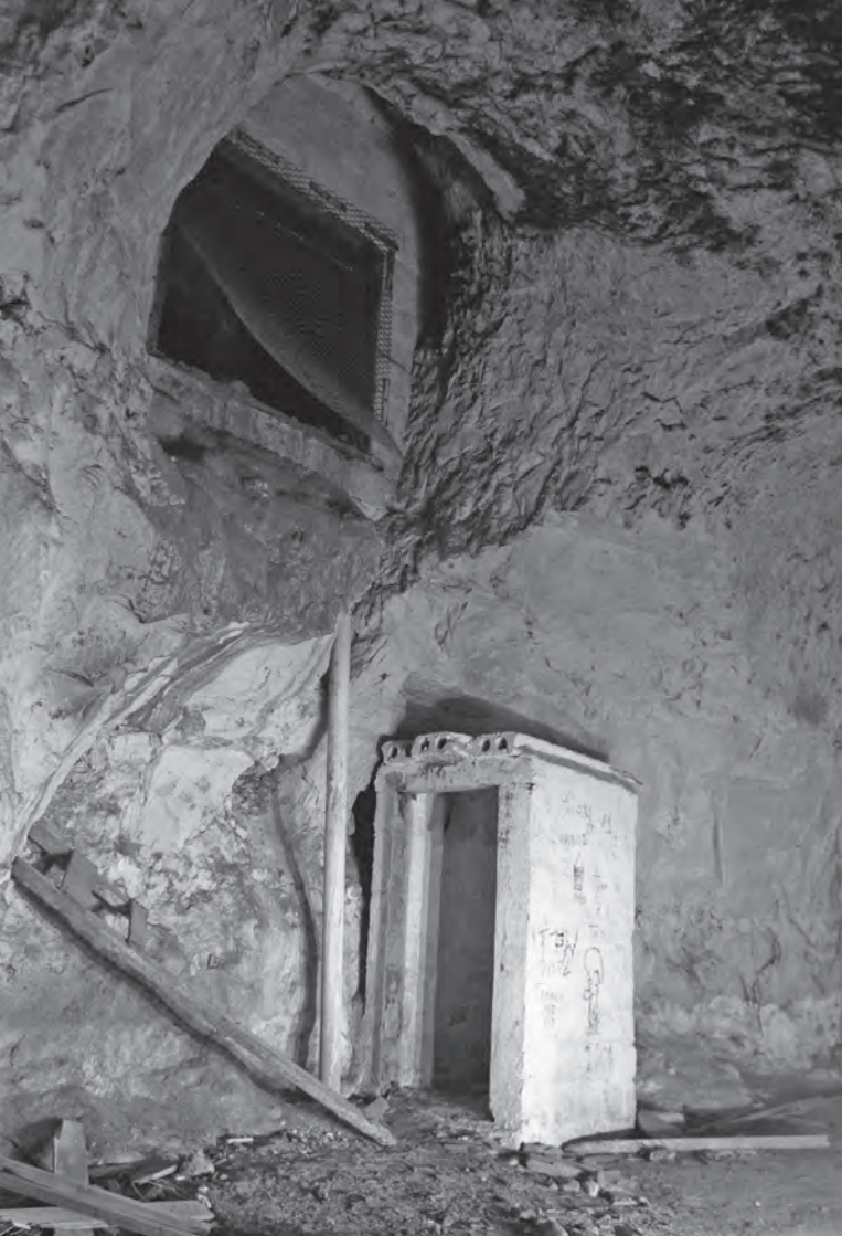
AFBEELDING 20: Tegen het plafond de uitmonding van de grote luchtschacht. Rechts het toilet voor de dames. (foto Rob Heckers, 2007)
