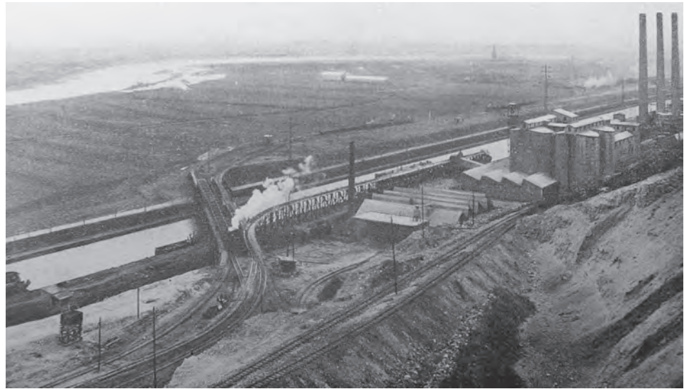
AFBEELDING 2: Gezicht vanaf de nog niet geheel afgegraven doorsnijding van de Sint-Pietersberg, met de voormalige cementfabriek van Lanaye langs het kanaal Luik-Maastricht en de speciale brug over dat kanaal voor het transport van de gronden. (foto uit: Santilman, H.N.F.-1940: Les travaux de Construction du canal Albert)
