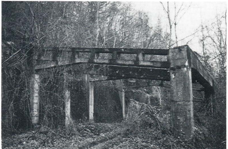
De betonnen geraamten van de ingangsbunker
